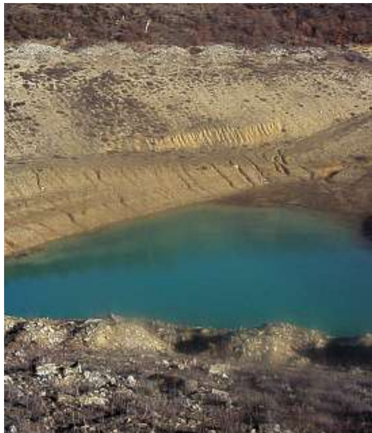
EJEMPLO DE Balsa con taludes excesivamente pronunciados, que impiden el escape de determinadas especies que acceden al agua
